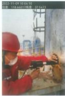
图 1 锅炉烟囱 (DA001) 检测照片
