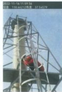
图 4 一车间-烯胺尾气吸收 (DA005) 检测照片
