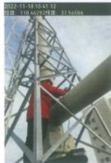
图 11 新戊合成工序甲醇尾气吸收排气筒 (DA013) 检测照片
