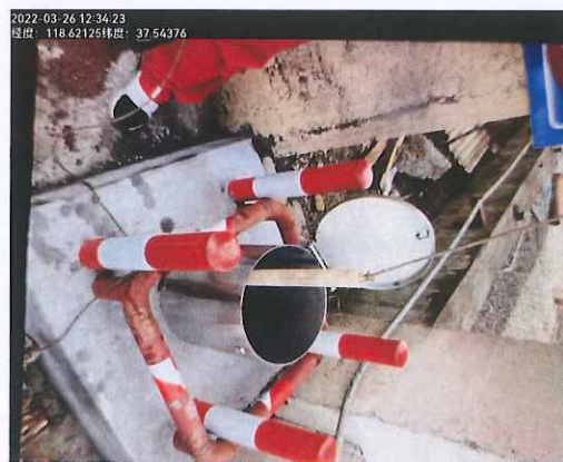
图 6 4#地下水采样照片
